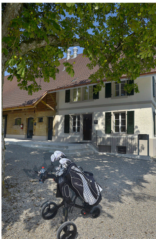
Das ehemalige Bauernhaus wurde in sanfter Renovation zu einem Klubhaus umgebaut.
